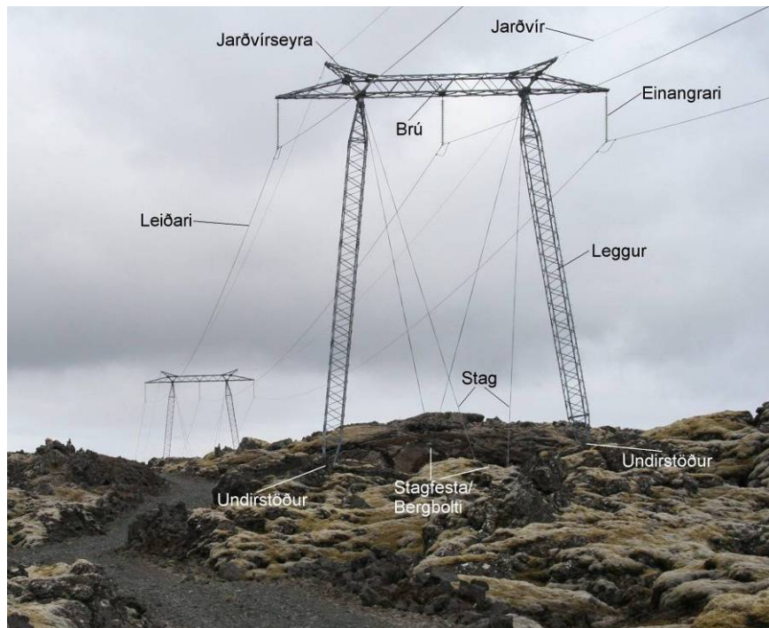
Mynd 2.5 Stagað M-mastur úr Búrfellslínu 3B (220 kV). Skýring á helstu hugtökum.
