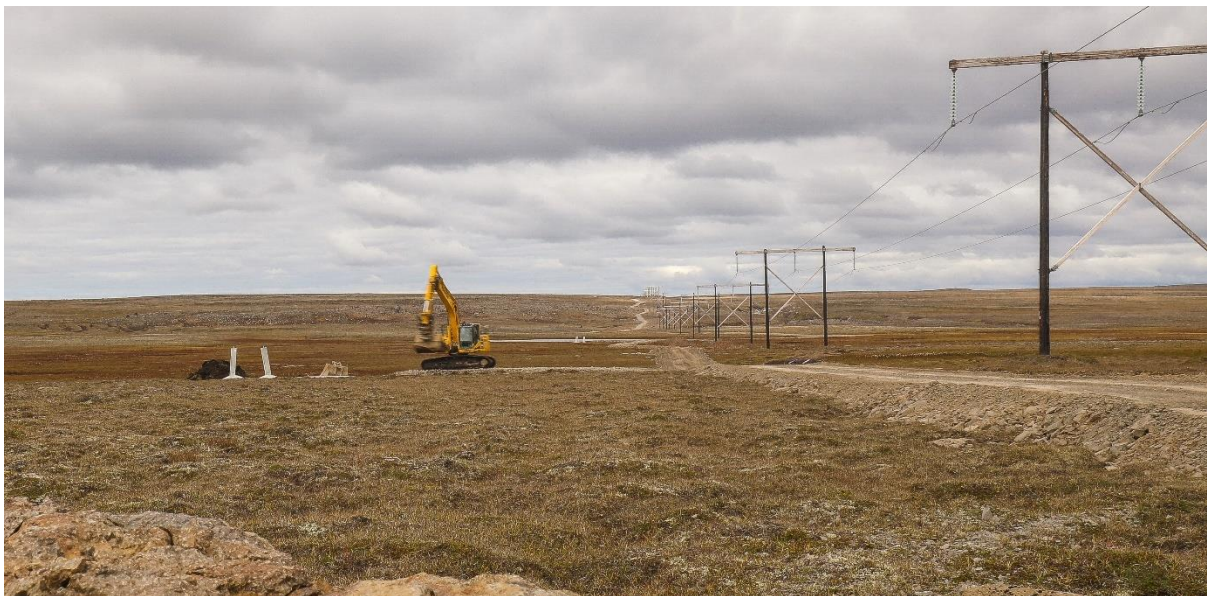
Mynd 6.17 Slóðagerð við Kröflulínu 3. Á myndinni sést núverandi 132 kV loftlína þar sem lagður hefur verið slóði samsíða og undirbúin mastraplön fyrir nýja 220 kV Kröflulínu 3.
