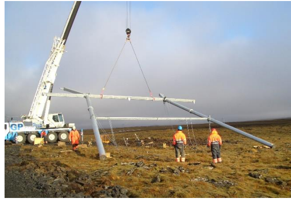
Mynd 6.12 Sýnt frá vinnu við samsetningu og reisingu stagaðs burðarmasturs af M-gerð með jarðvírseyrum. Myndirnar eru frá byggingu Reykjaneslínu 1.
