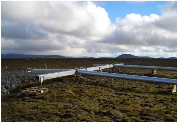
Mynd 6.12 Sýnt frá vinnu við samsetningu og reisingu stagaðs burðarmasturs af M-gerð með jarðvírseyrum. Myndirnar eru frá byggingu Reykjaneslínu 1.
