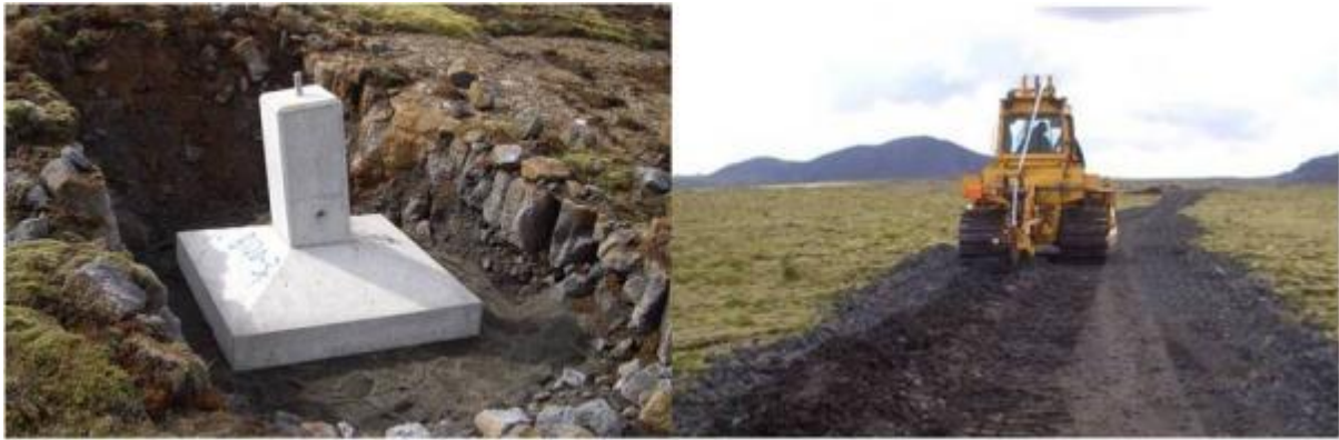
Mynd 6.5 Til vinstri má sjá forsteypta undirstöðu M-masturs og til hægri sést hvernig jarðskaut er plægt í kant á vegslóða.
