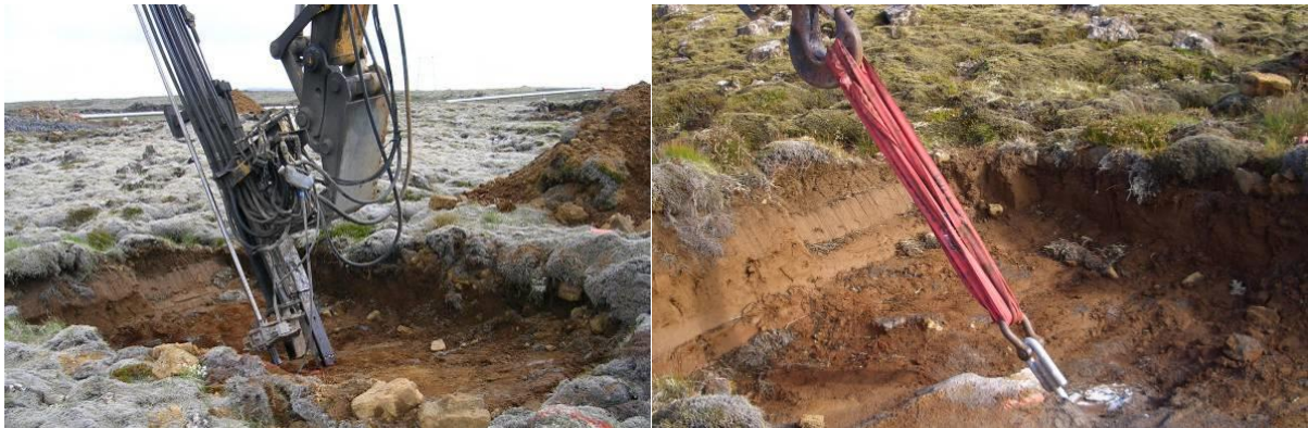
Mynd 6.7 Til vinstri sést hvar borað er fyrir bergbolta. Myndin til hægri sýnir bergboltaprófun.
