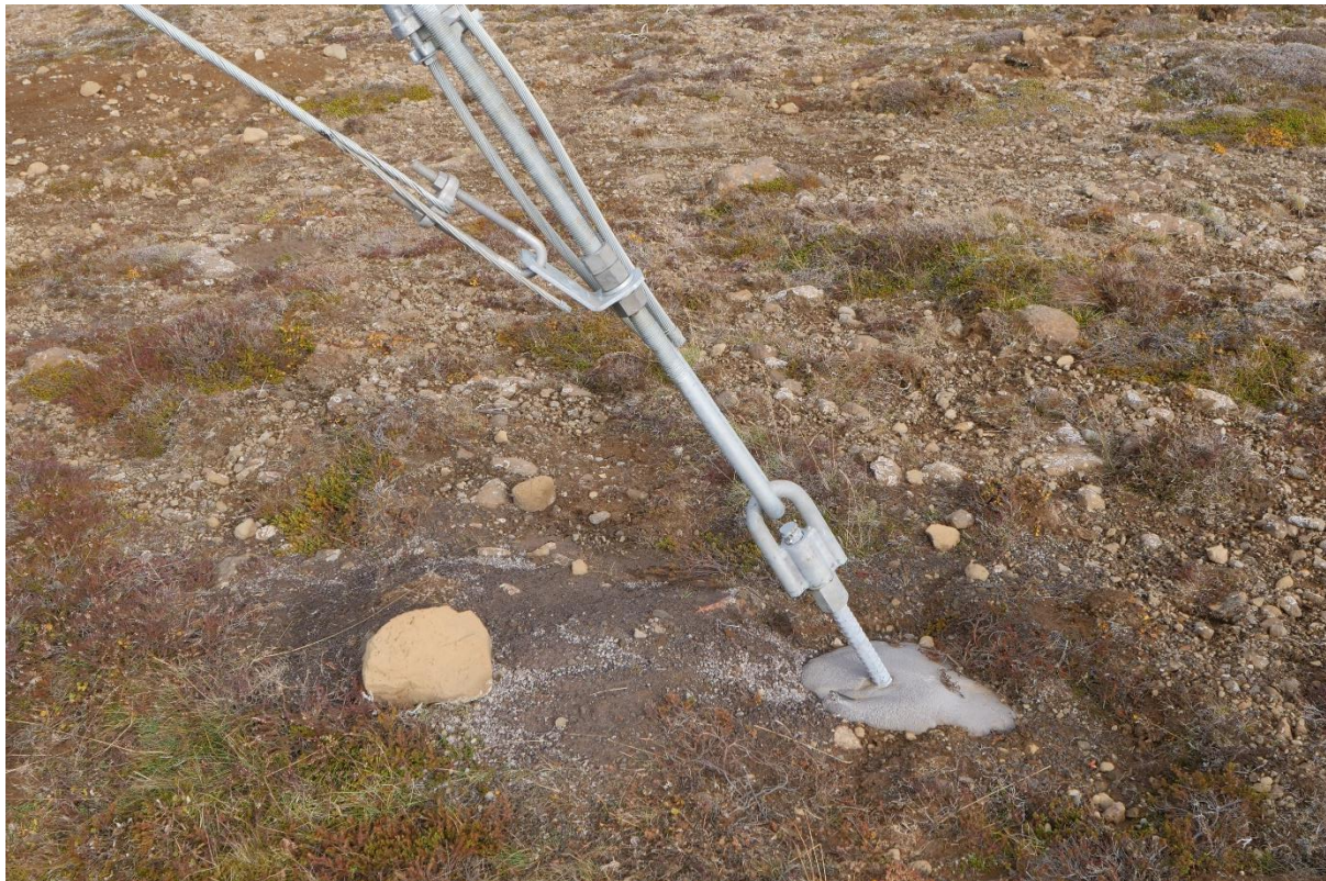
Mynd 6.8 Bergbolta í fóðurrör. Rask á yfirborði lands er varla til staðar.
