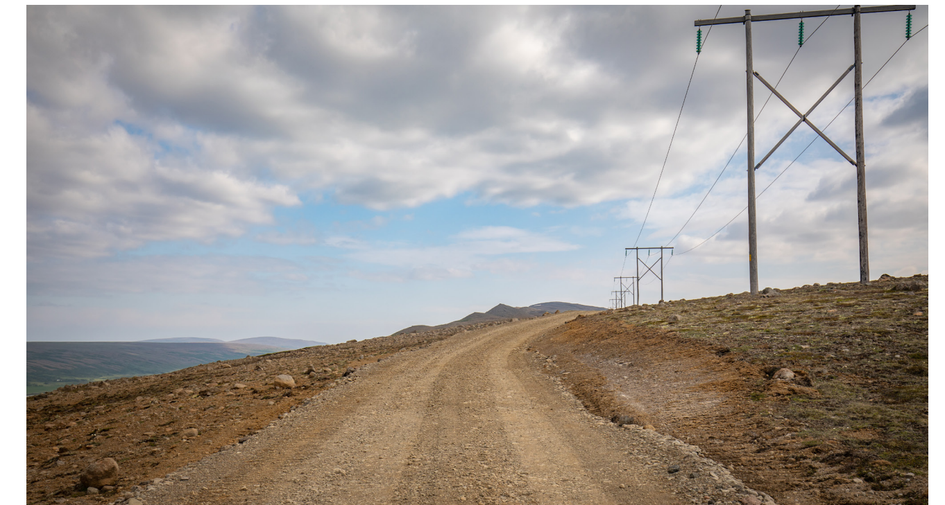
Dæmi 4. Nýleg línuslóð vegna Hólasandslínu 3
