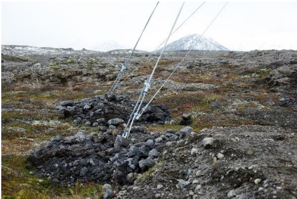
MYND 5.1 Minnst rask mældist við mastur TR1-10 í Þeistareykjalínu. Mastrið stendur í grónu helluhrauni.
