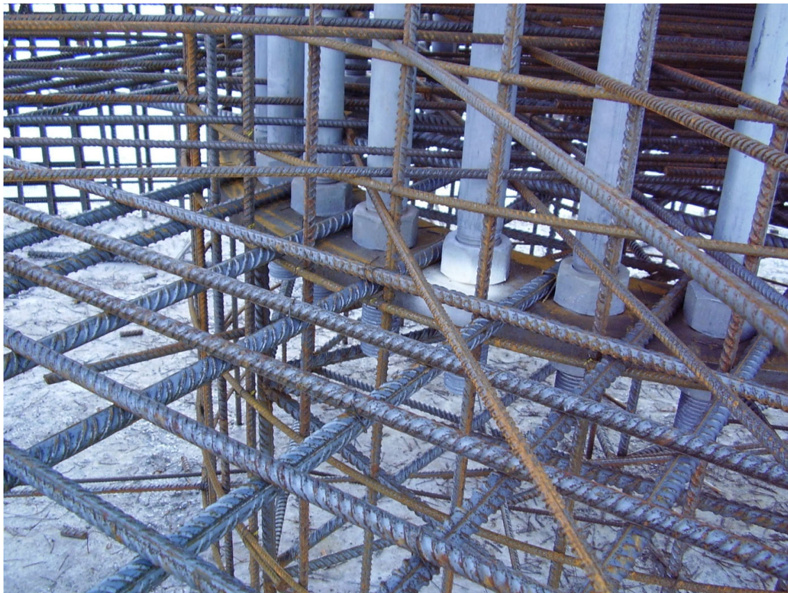
MYND 3.2 Steypustyrktarjárn í undirstöðum. Ljósmynd EFLA.
