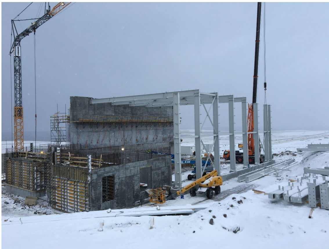
MYND 3.6 Frá byggingu tengivirkis á Bakka veturinn 2016-2017. Ljósmynd Landsnet.
