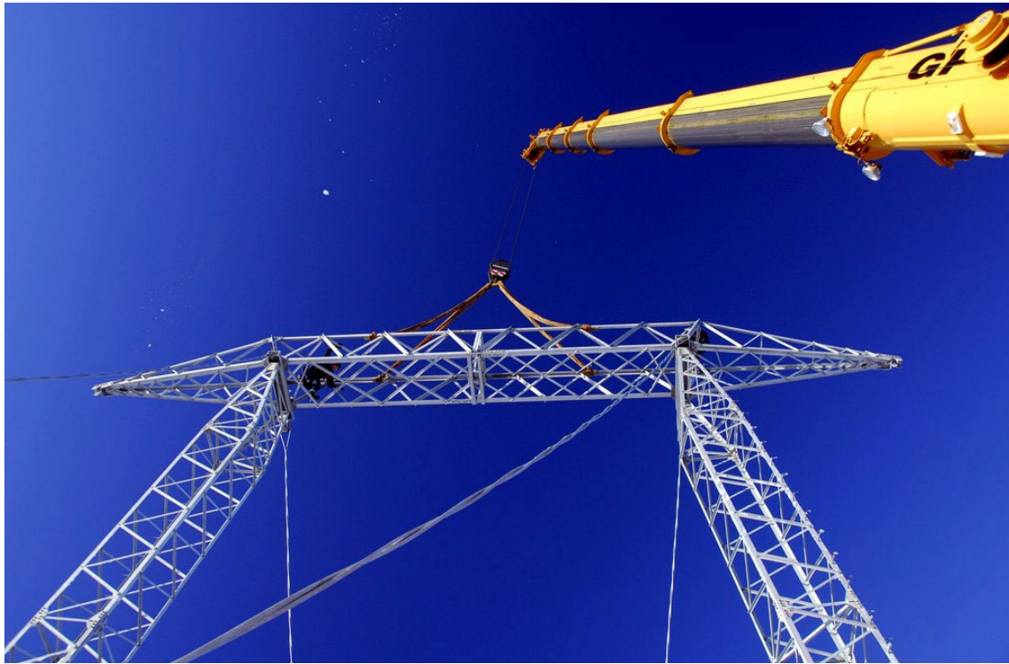
MYND 3.1 Reising háspennumasturs. Ljósmynd EFLA.
