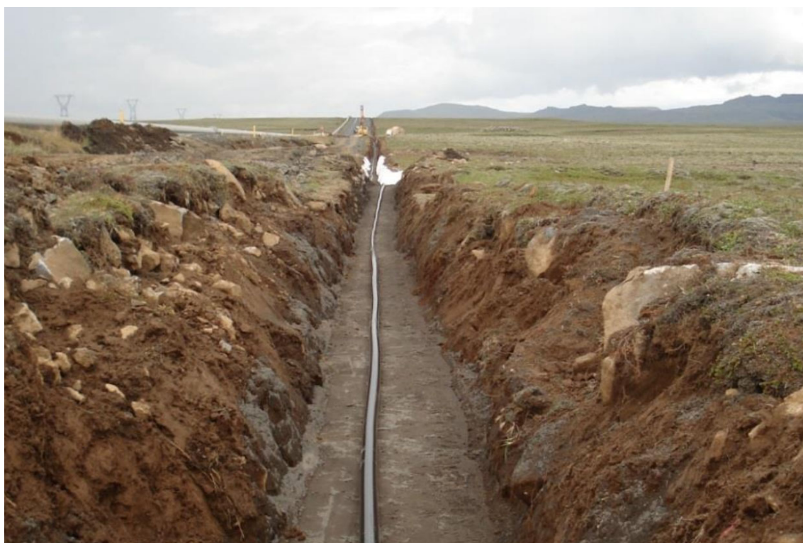
MYND 3.7 Lagning 132 kV Nesjavallalínu 2 árið 2009 í hefðbundinn opinn skurð [24].
