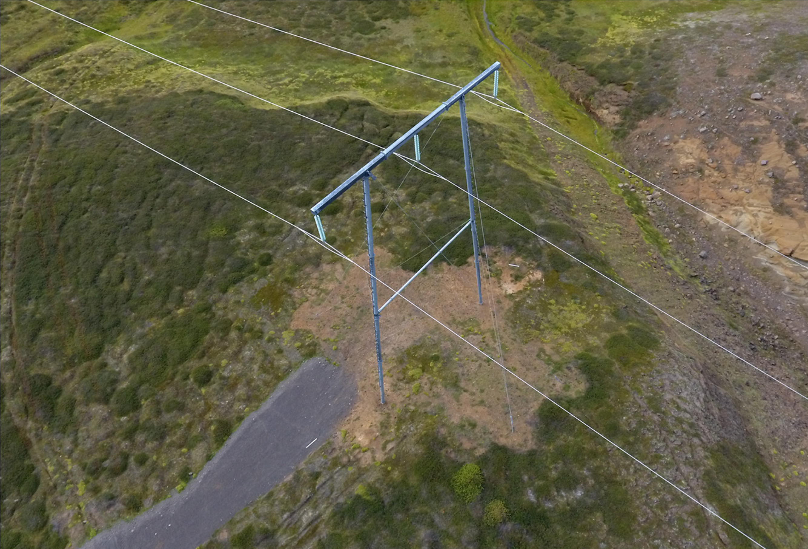
Mastur í nýrri 220kV byggðalínu
