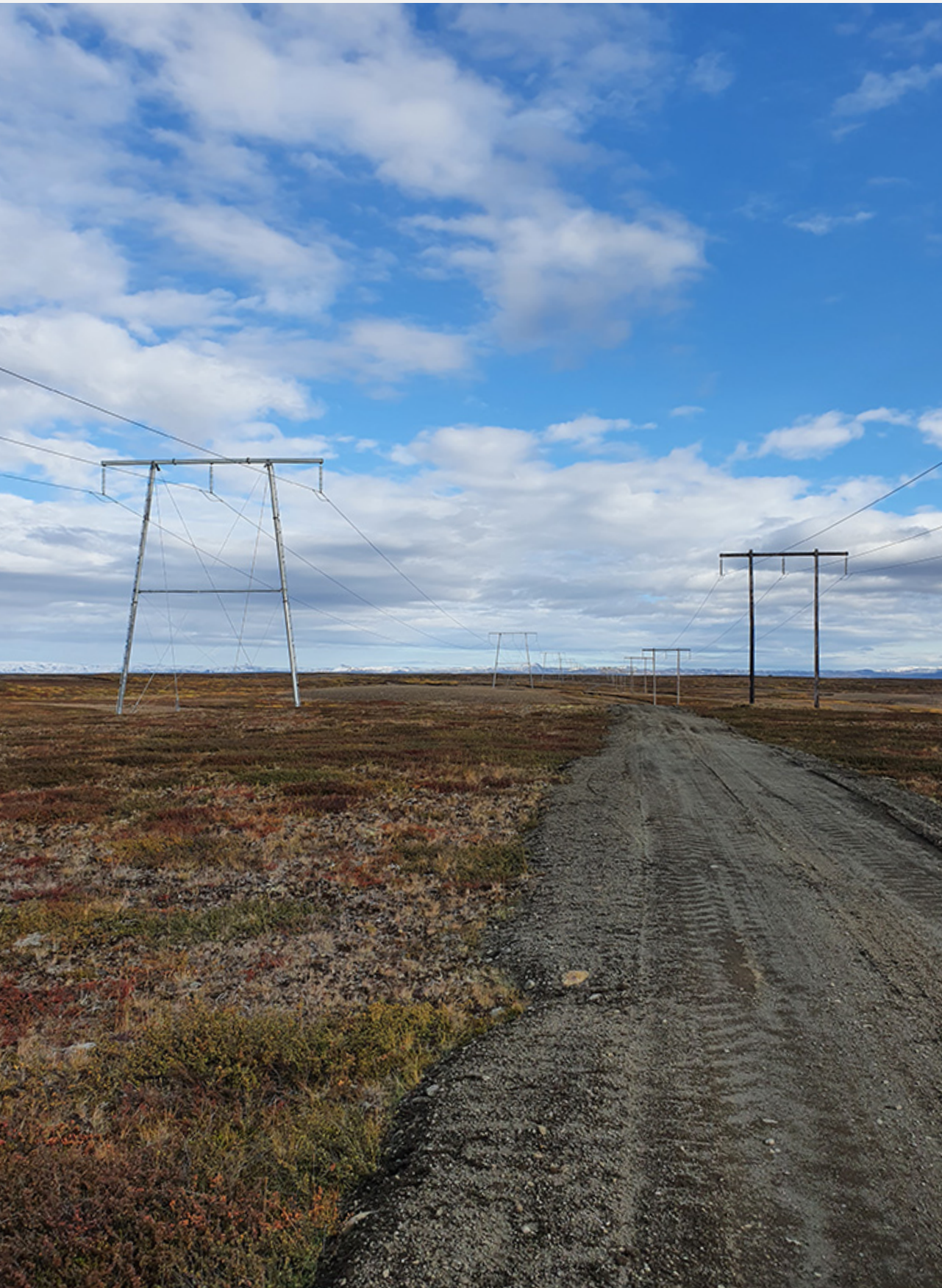
Kröflulína 3 220 kV og Kröflulína 2 132 kV
