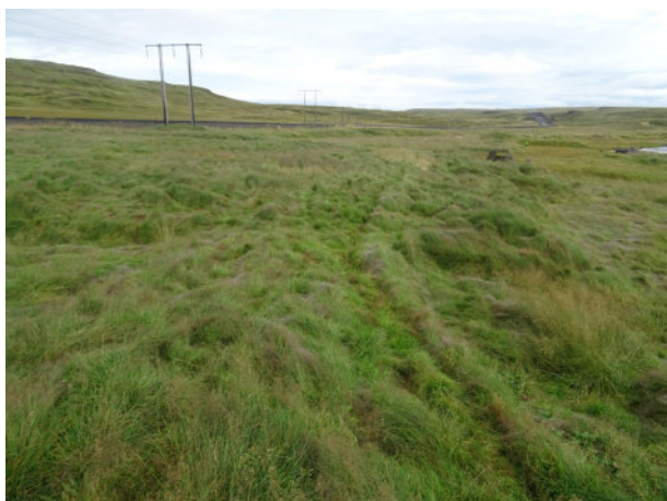
Upphlaðin mýrarbrú 001_08 í Sæluhúsflóa, horft til norðausturs.
