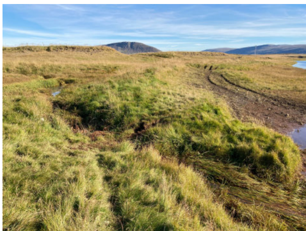
Upphlaðin brú 037_02, horft til suðausturs.
