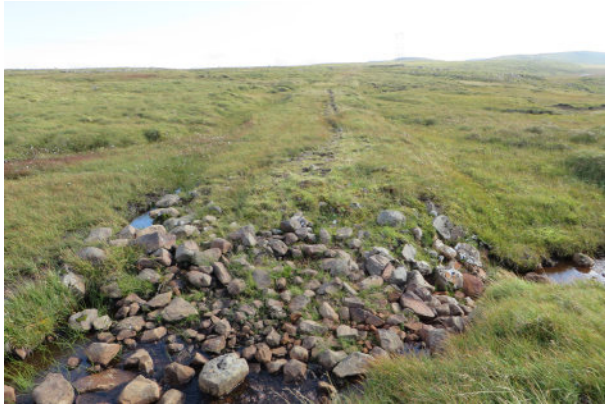
Upphlaðin mýrarbrú 001_05, horft til suðausturs.
