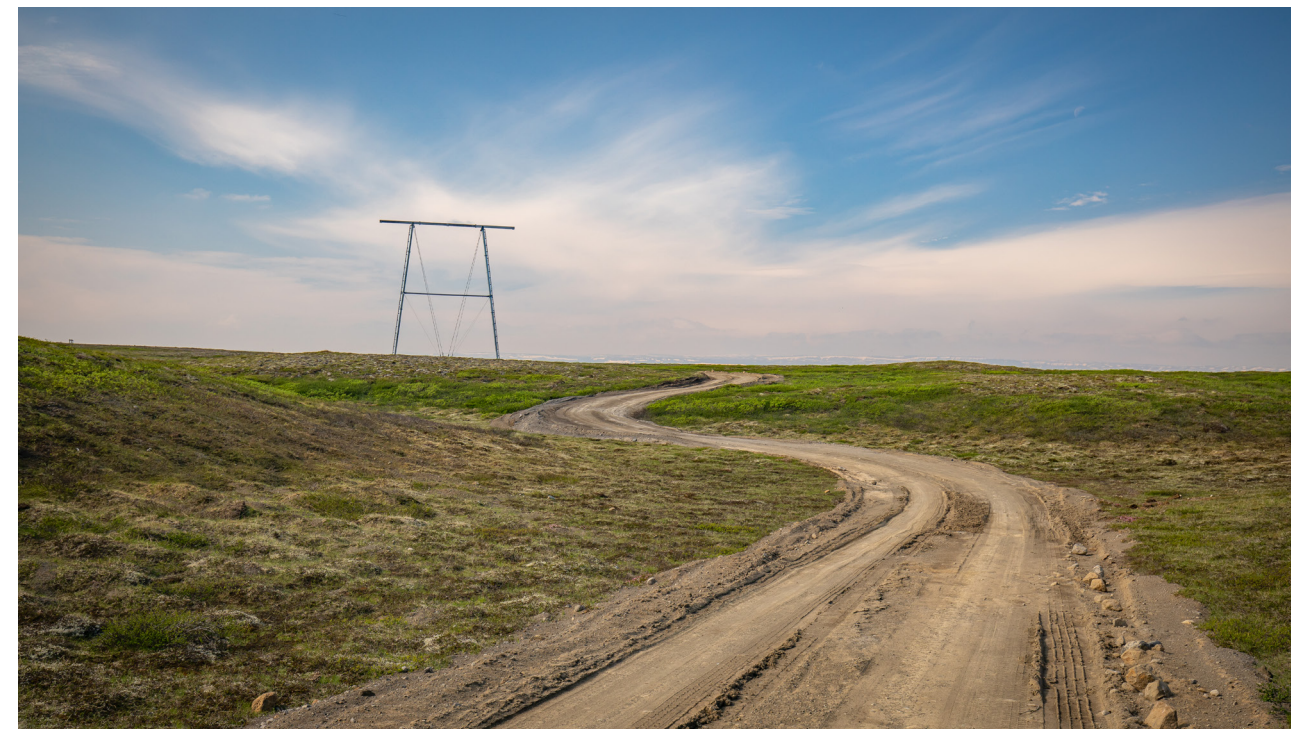
Dæmi 3. Nýleg línuslóð meðfram Hólasandslínu 3
