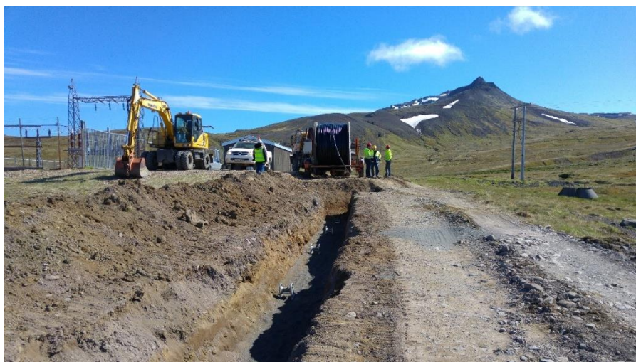
MYND 4-21: LAGNING GRUNDAFJARÐARLÍNU 2.
