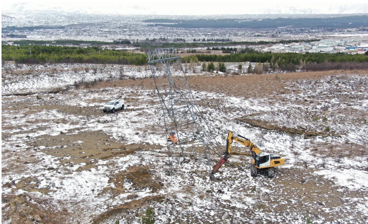
MYND 4-6: NIÐURRIF GÖMLU RAUÐAVATNSLÍNU 1 Á HÓLMSHEIÐI.
